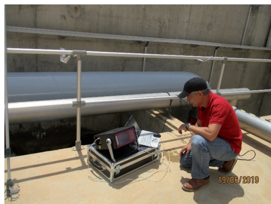
FIGURA 2. Medición en línea, a la salida de un filtro.
